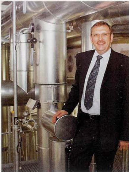
Hohe Investitionen auch für zuverlässige Wärmeversorgung: Peter Bursy, Kaufmännischer Geschäftsführer der Stadtwerke Stein, zeigt das moderne Heizkraftwerk im Stadtteil Deutenbach.
